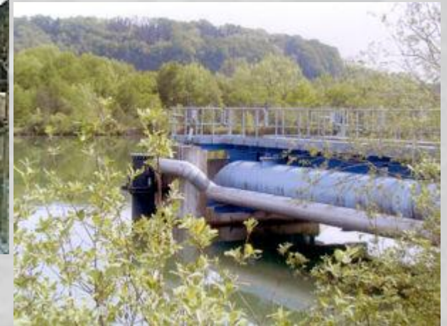
Kühlwasserentnahme Bild: Peer- Wasserbau
