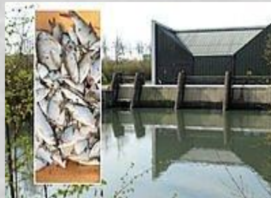
Fischschäden Schöpfwerk Deggendorf Bild: Deggendorfer Zeitung 04/2013
